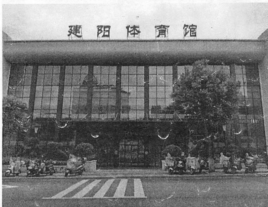
图1 建阳体育馆外景图
